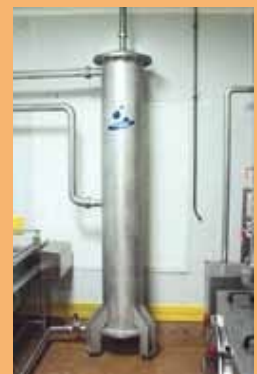
Dans le ballon vertical l'ozone se dissout dans l'eau.
